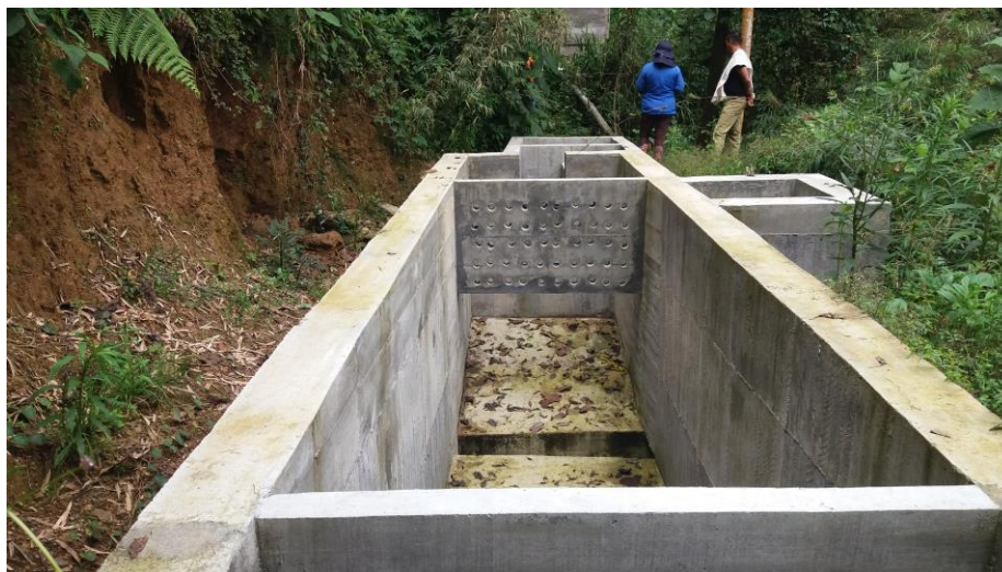
Imagen 9. Obras de optimización de la bocatoma del acueducto existente dentro de la Reserva
